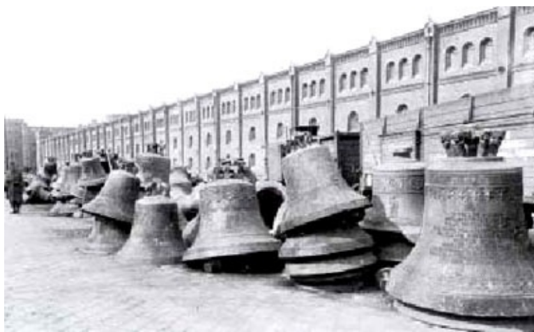
Campanas austriacas preparadas para ser fundidas. Las necesidades de la guerra total.
